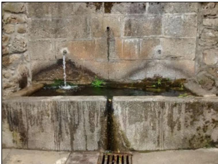
Las aguas de esta fuente serán canalizadas por un colector de 110 mm. de diámetro bajo la rasante de las calles a lo largo de 100 metros, hasta su entronque con el colector existente en la arqueta AiSC-9, junto a la fuente de la Plaza de la Constitución.
