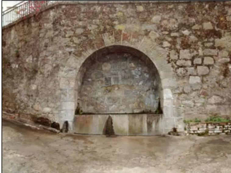
Esta fuente se localiza en la parte trasera de la Iglesia. Para su desconexión de la red de saneamiento se ejecutará un colector de 110 mm de diámetro que entroncará con la arqueta AiSC-2 a 40 metros de distancia, y como en el caso anterior, se desviarán a la red de riego.
