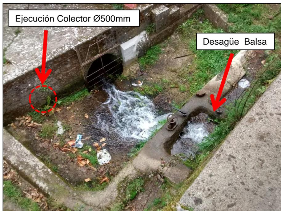
Desagüe de la balsa de riego a colector existente. En este lugar se emplazará la nueva arqueta para conducir las aguas al nuevo colector de Ø500 mm.
